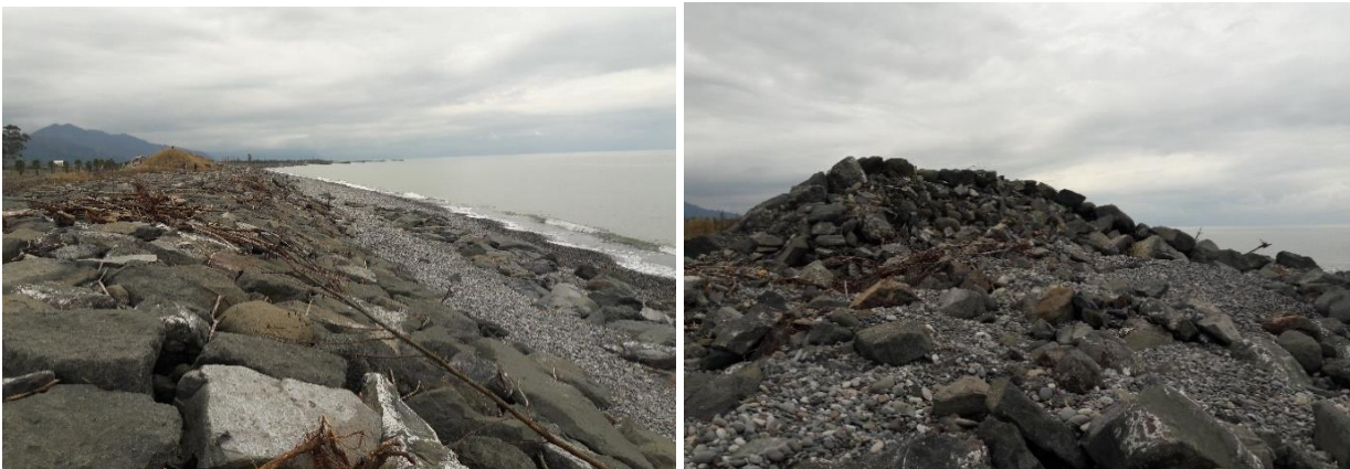
სურ. 3.4.1.10. ლოდებისაგან მოწყობილი ნაპირსამაგრი ნაგებობა
