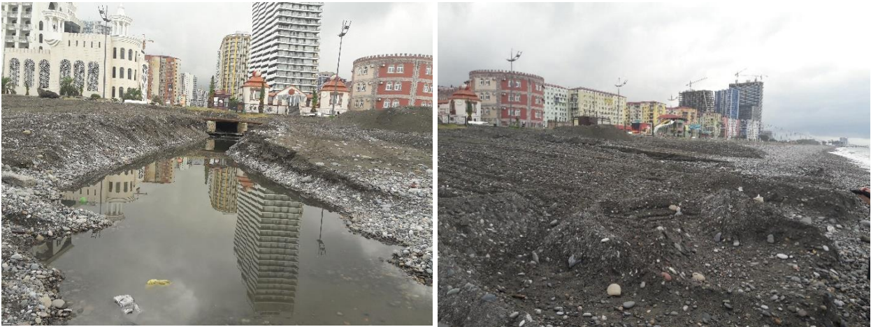
სურ. 3.4.1.4. ზღვაში ჩამდინარე არხი, სანაპირო ზოლში მიმდინარე მშენებლობა
